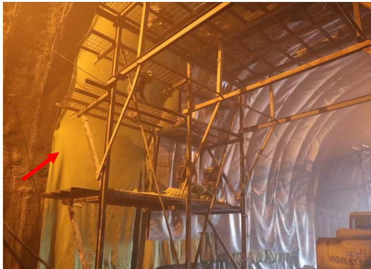
شکل ۷- نصب لایه ژئوتکستال (علامت فلش)
