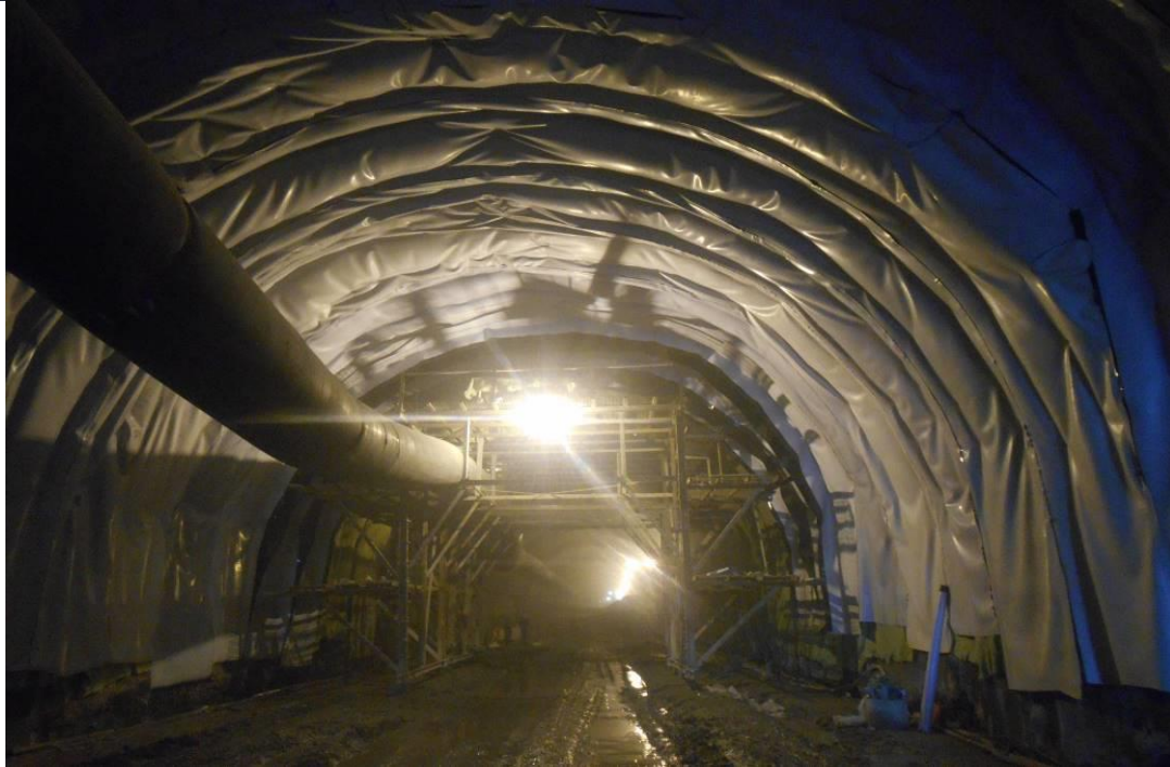
شکل ۹- نمایی از نصب لایه ژئوممبران در تونل باغان
