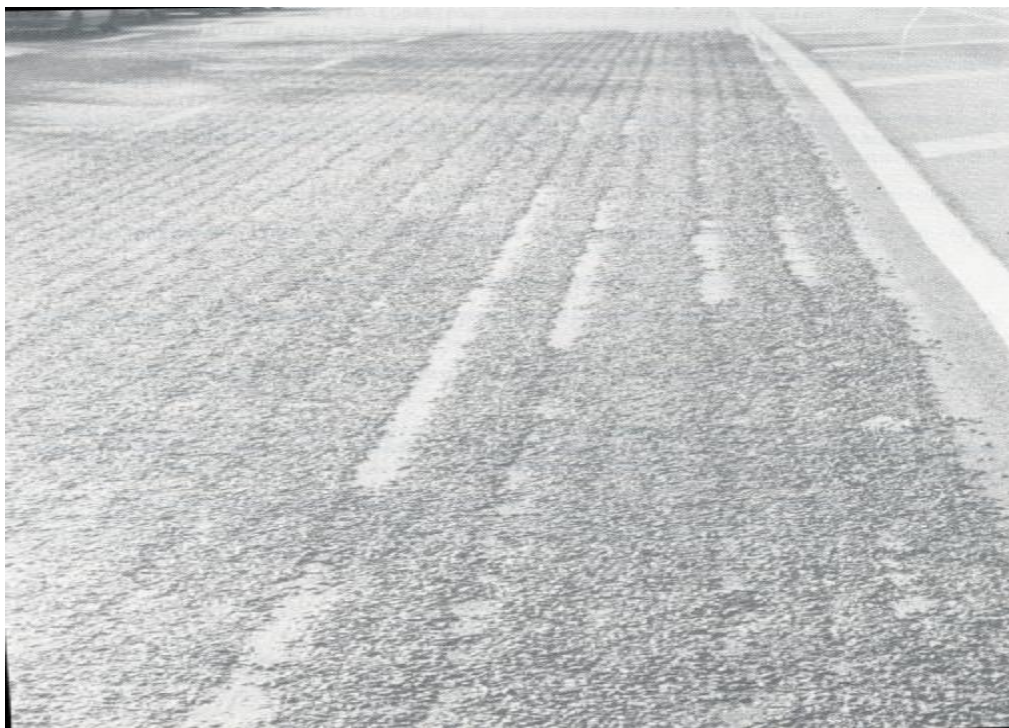
گرشدگی سطح راه به علت استفاده از چسباننده با ویسکوزیته بالا و در درجه‌حرارت خیلی کم
