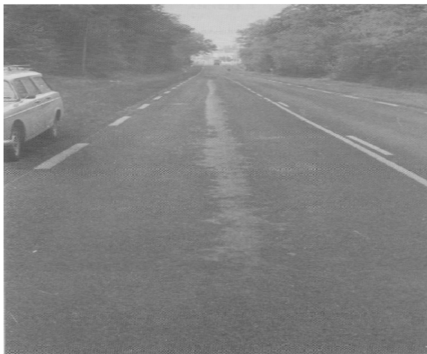
عریان‌شدگی و جداشدگی سنگدانه‌ها به دلیل پخش ناکافی چسباننده (گرفتگی افشانک پخش)
