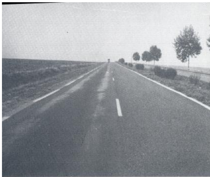
لکه‌های روزدگی قیر بخاطر اضافه‌بودن میزان چسباننده در باند عبوری کندرو (ترافیک سنگین بر روی جاده‌ای با دو باند سواره‌رو جداگانه)
